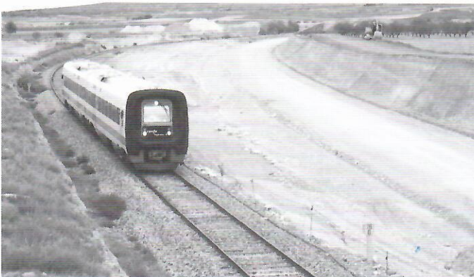
Tren regional nº 8513 Zaragoza-Valencia a la altura del km 78 entre Longares y Cariñena, un lugar en donde se está ejecutando una de las rectificaciones de trazado previstas en el tramo Muel-Cariñena.
