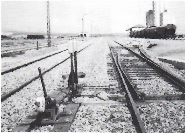
Enclavamiento Boure en la vía 1. ª (Estación de Cariñena). Foto: Antonio Galindo.
