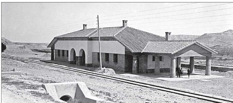
Estación de Botorrita de la línea Caminreal-Zaragoza durante su construcción, compatibilizando el servicio del ferrocarril de vía estrecha Cariñena-Zaragoza, que discurre en sus proximidades. Año 1933. Foto: Juan Antonio Cifuentes. Archivo CIFCCC
