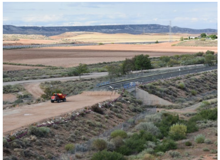
Obras de reparación del terraplén del pk 86 (Torrubia) entre Longares y Muel. 23-julio-2019. ■ Archivo CIFCCC.
