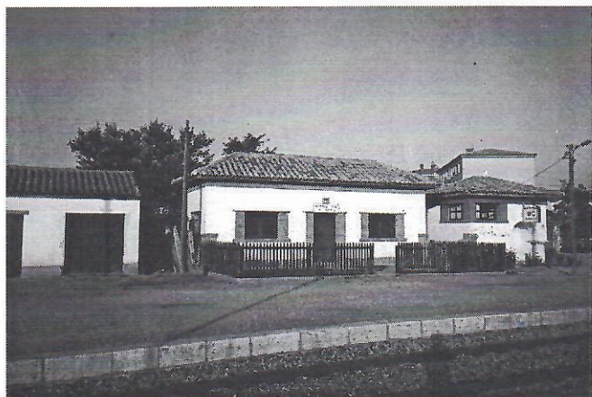
Estación de Cariñena, febrero de 1993.
