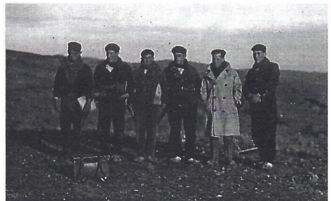
Equipo de replanteo del Ferrocarril Caminreal-Zaragoza entre Villarreal y Encinacorba. El segundo por la derecha es el Ingeniero Técnico D. Luis Dourdil. 1928.
