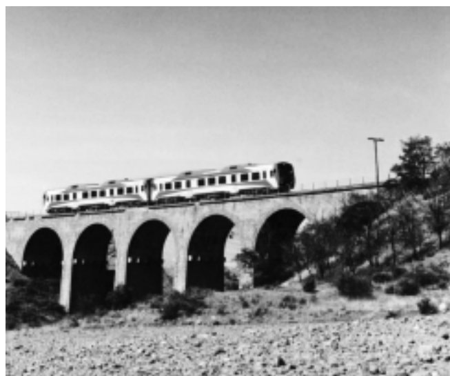
En los 25 kilómetros que separan Villarreal de Huerva y Cariñena, además de realizar un importante movimiento de tierras, fue necesario la construcción de nueve túneles y dos viaductos, el de Atalaya (en la imagen) y el del “Colmenar”.
