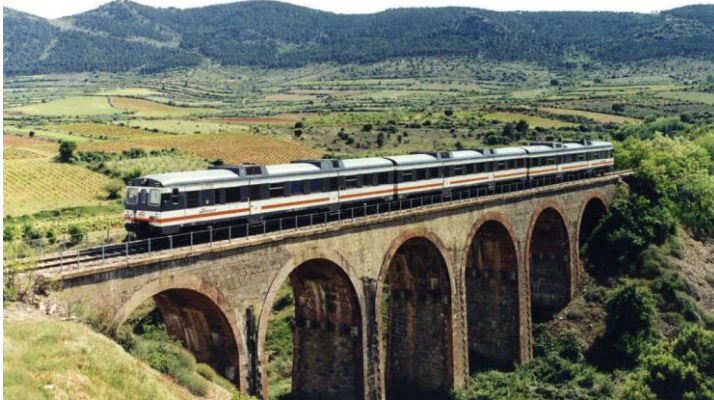
Tren regional nº 8503 Zaragoza-Valencia prestado por un automotor MAN s/592 en el viaducto "El Colmenar" entre Encinacorba y Villarreal, subiendo el Puerto del Alto el día 24 de mayo de 1999.
