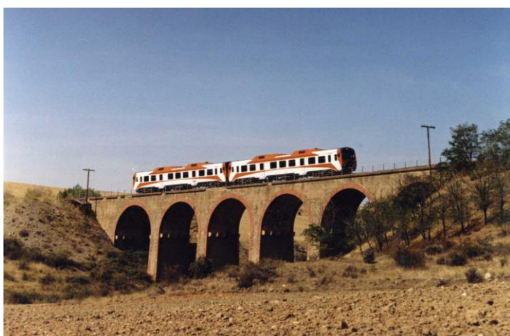
Cuando los automotores FIAT s/596 estuvieron temporalmente sirviendo la relación Zaragoza-Valencia, era fácil poderlos ver circular en doble composición. Regional nº 32.402 Valencia-Zaragoza sobre el viaducto de "Atalaya" entre Villarreal y Encinacorba el día 24 de septiembre de 2000.
