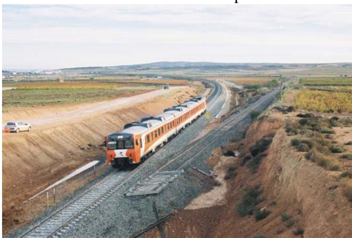
Primera circulación por la nueva variante de Longares a la altura del punto de conexión con el antiguo trazado. Tren 8511, 13-Nov.-2006.
