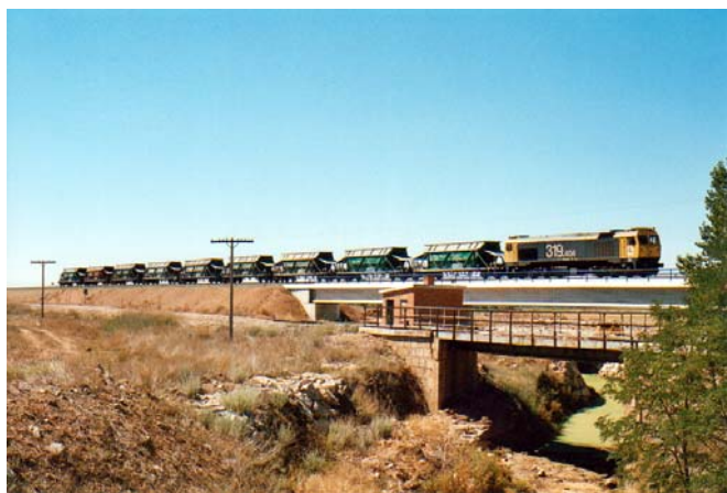
Tren de clíncker para Santa Eulalia circulando por el nuevo puente sobre el río Jiloca. En primer término antiguo puente del anterior trazado. 4 de Agosto de 2005. Foto: José Elena.
