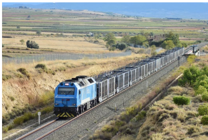
Tren de mercancías con plataformas portautos vacías, circulando a la altura del nuevo apeadero de Longares. Al fondo y entre la vegetación se adivina la antigua estación de la línea Caminreal-Zaragoza fuera de trazado. 6/10/2020. ■ Archivo CIFCCC.
