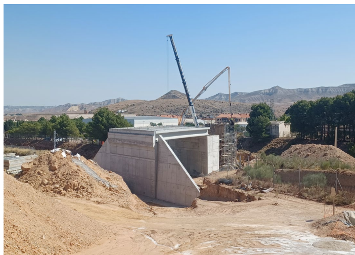
Estructura del nuevo paso superior del pk 92+707 en Muel. 18/9/2025. ■ Archivo CIFCCC.
