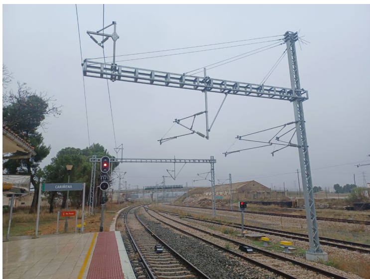
Los elementos de la futura electrificación entre Zaragoza y Teruel, ya son visibles en la estación de Cariñena. 26/12/2025. ■ Archivo CIFCCC.
