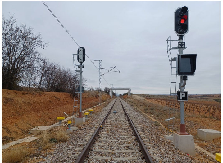
La instalación de la nueva señalización se encuentra muy avanzada. Trayecto Encinacorba-Cariñena. 25/12/2025. ■ Archivo CIFCCC.
