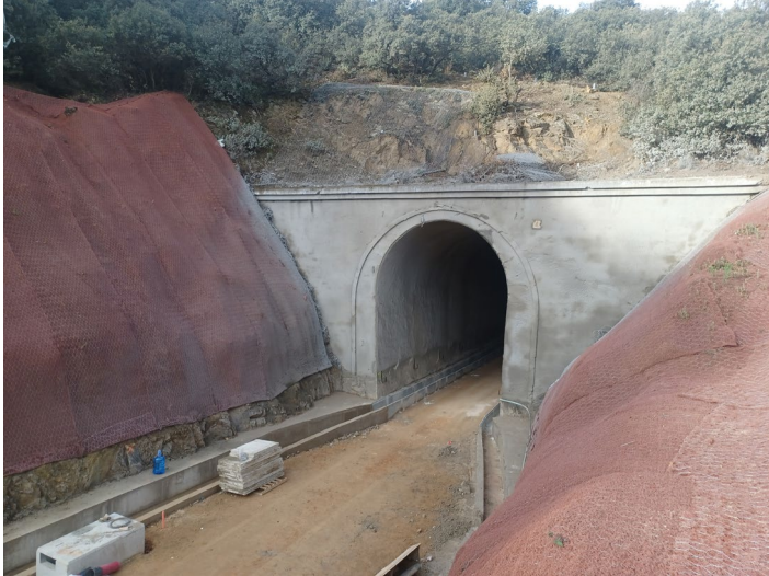
Aspecto que presenta la boca sur del túnel nº 4, con su plataforma ya rebajada. Trayecto Villarreal-Encinacorba. 6/12/2025. ■ Archivo CIFCCC.
